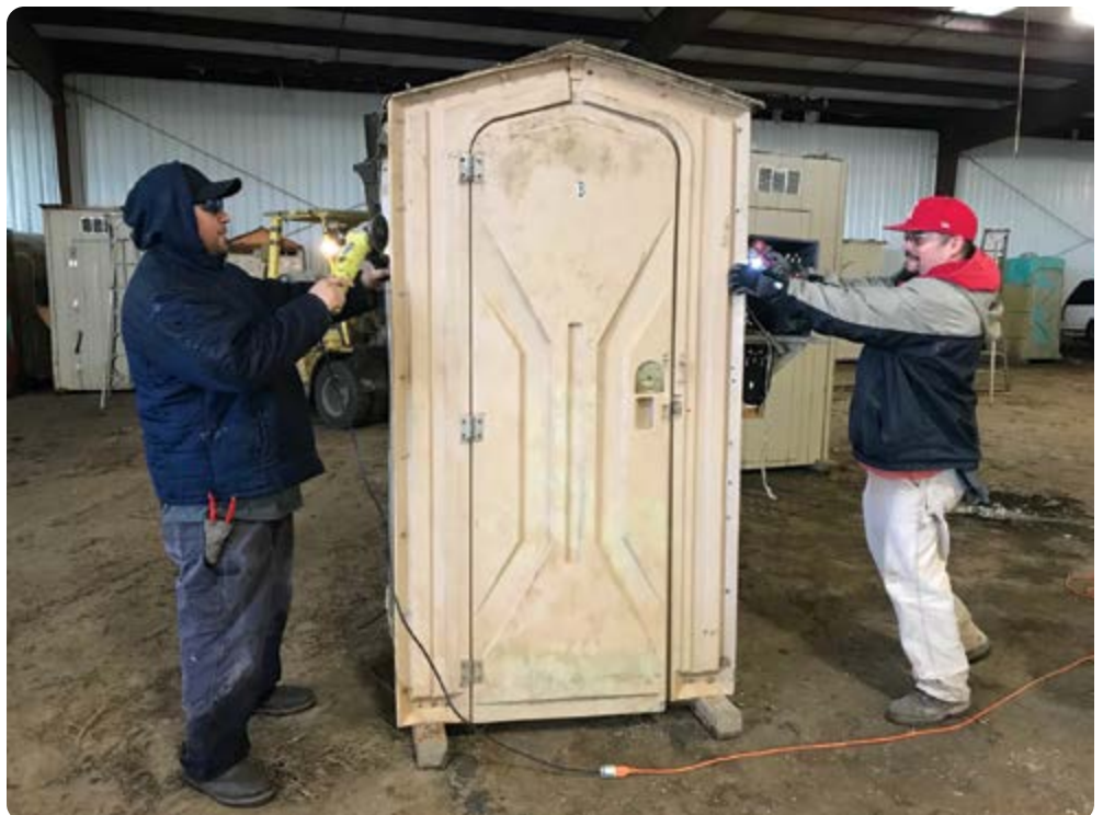
Heriberto Plasencia (izquierda) y Carlos Aparicio trabajan reparando baños.
