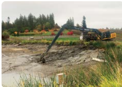
Jeremy Imes en la excavadora de largo alcance y Jorge Magaña en el camión de volteo se unen para sacar el lodo de la laguna de Cottrell.
