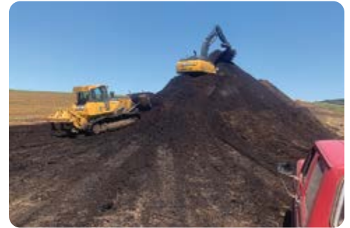
¡Luís DeLucio en la topadora y Jeremy Imes en la excavadora trabajan juntos para amontonar 7,000 yardas de compost!
