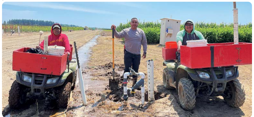
El equipo de riego de goteo mantiene muchas millas de líneas de goteo para mantener el sistema funcionando. De izquierda a derecha, Federico Santiago, Omar Carreño y Albino Hernández.
