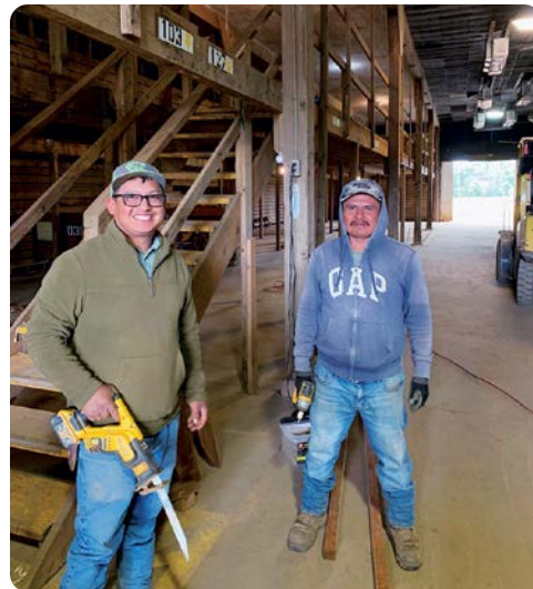
Rafael López y Martín González trabajan en reemplazar las tablas en malas condiciones en el refrigerador.
