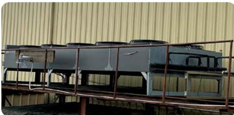
**En el enfriador de Barlow, los ventiladores de la unidad condensadora exterior toman el calor extraído del interior del edificio y lo sueltan hacia fuera.**
