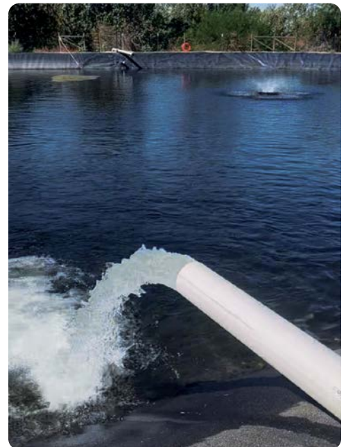
Se bombean 750 galones por minuto de agua fresca del río a la laguna. ¡A los árboles les va a encantar beber esta agua!
