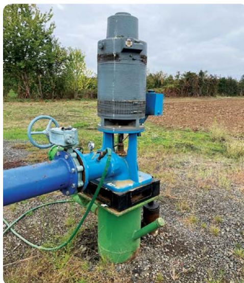
Ejemplo de una bomba de pozo tipo turbina. Motor eléctrico en la superficie, bombea hacia el fondo del pozo.
