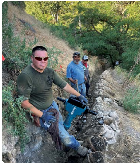
Abraham Ibarra, Aurelio Gonzales y Rogelio Hernández trabajan con martillos neumáticos, picos, palas y moviendo a mano grandes piedras para excavar una zanja con una inclinación del 30% para la nueva tubería principal de riego. ¡Fue un trabajo duro!
