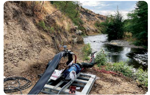
Nueva bomba y línea de succión instaladas y listas para usar
