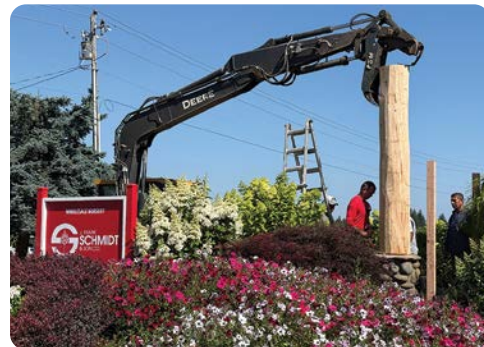
Gordy Webster y el equipo de mantenimiento colocando postes para el letrero de la entrada principal recién renovado.
