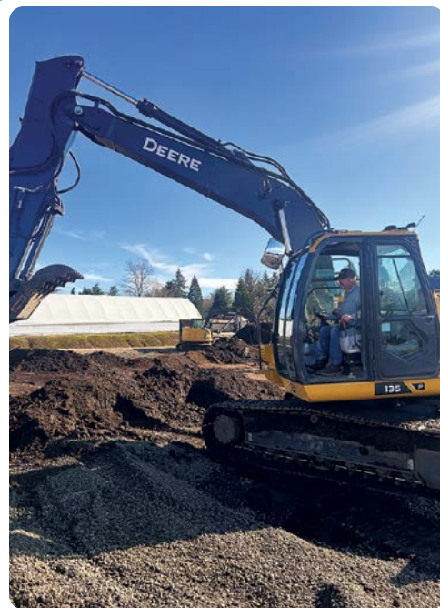
Jeremy Imes maneja la excavadora de gran tamaño, con otra excavadora y el camión de volteo al fondo para limpiar el camino para nuestro nuevo patio de grava.
