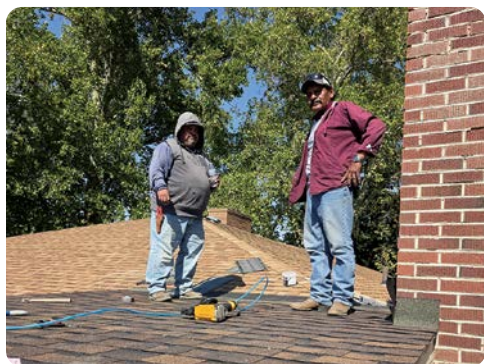
Miguel Reyes y Oscar Ponce haciendo reparaciones en la azotea tejado de una casa de nuestro rancho para asegurarse de que esté preparada para el invierno.
